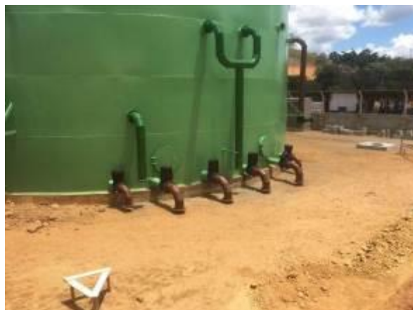
Foto 02: Vista válvula Reator UASB
