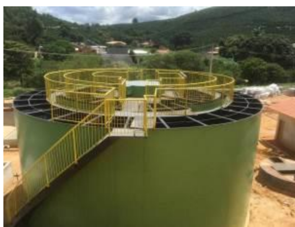
Foto 02: Vista Superior UASB
