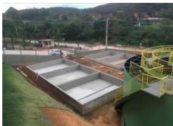
Foto 02: Leito de Secagem Reforma
