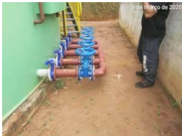
Foto 03: Válvulas Descarte de Lodo
