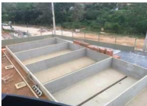
Foto 01: Leito de Secagem Novo
